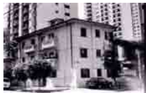
As construtoras começam a procurar o bairro para construir prédios. Moema era considerado subúrbio, os terrenos eram grandes e baratos. Isso gera uma rápida valorização da região, modificando sua estrutura.
