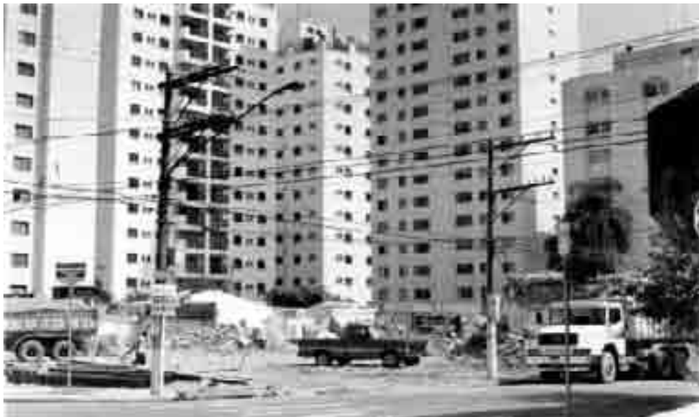
foto 13: Construções demolidas para dar lugar a prédios, ao fundo a paisagem cada vez mais comum no bairro. (foto: Glauco Rocha, 2002)
